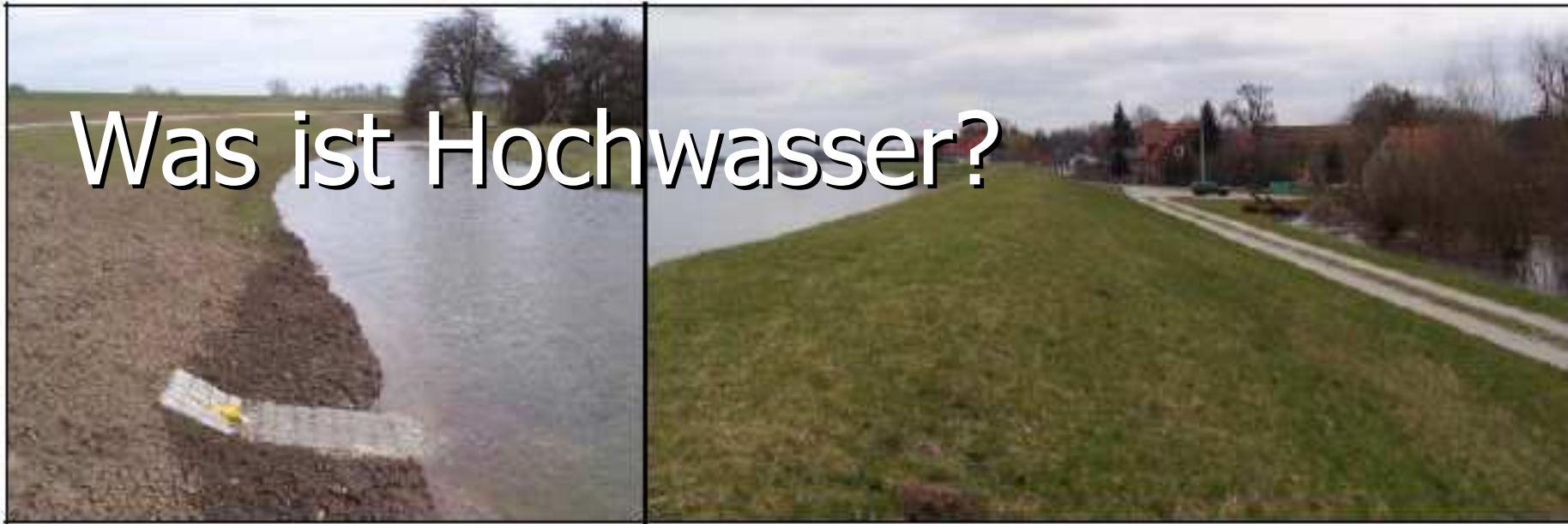
Abbildung 21: Sanierte Alanddeiche; Foto links zeigt die Dränageleitung mit dem Qualmpolder [Foto: Koch, A. (10. April 2006)]
