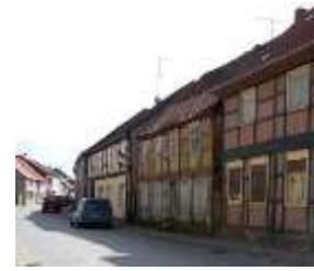
Abb. XII: Leerstehendes Gebäude in Werben
