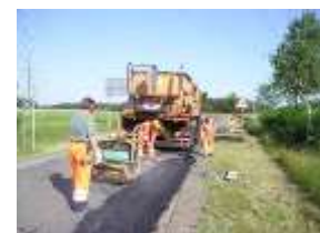
Abb. XVIII: Heißasphalt einbauen
