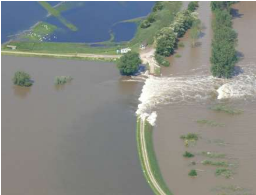
Abb. 39: Deichbruch bei Fischbeck im Juni 2013 213
