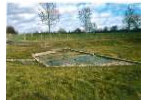
Abb. L: Regenwasserbehandlungs- anlage B 189 bei Groß Schwechten
