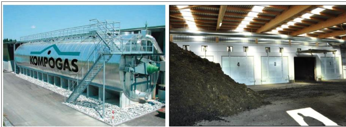
Abbildung 29: Fermenter einer kontinuierlichen (links) und diskontinuierlichen (rechts) Vergärungsanlage
