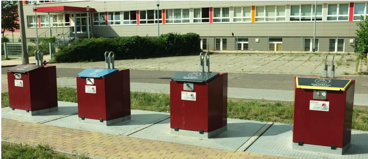
Abbildung 35: Erfassung von Restabfall und Wertstoffen über Unterflurcontainer im Umfeld von Großwohnanlagen im Stadtgebiet Stendal (Foto: Böhm)
